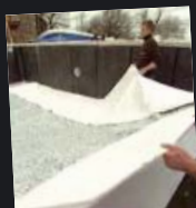
Pose du liner
